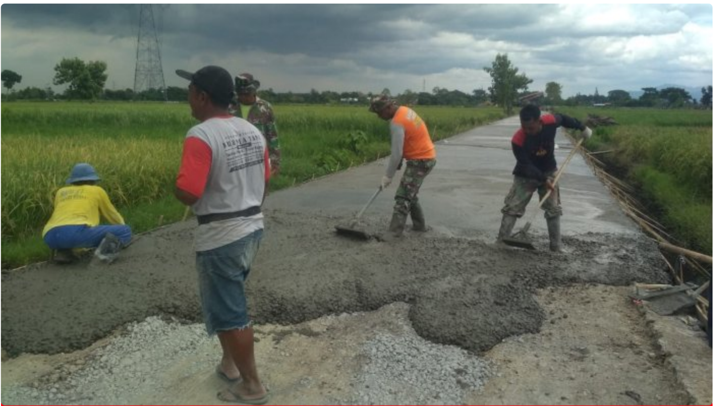
Puasa Bukan Halangan Bagi Satgas TMMD Kodim 0723 Klaten
